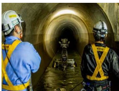
ロボットを駆使した 下水道管理
