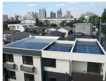
写真② 賃貸住宅への太陽光発電パネル設置
