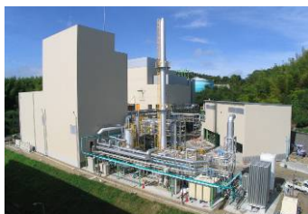
①100%リサイクルを実現したガス化溶融施設
