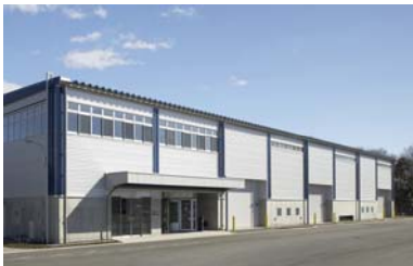
三和グループ試験センター 製品の性能確認を行うための試験装置を備えた三和グループ試験センター。製品試験の充実により、さらなる安全・安心・快適を提供します。
