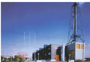
①札幌工場全景
