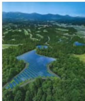
メガソーラーパネル （グランドエクシブ那須白河隣地）
