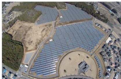
茨城県水戸市鯉淵町 自社発電所
