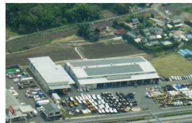
太陽光パネル設置の 本社工場
