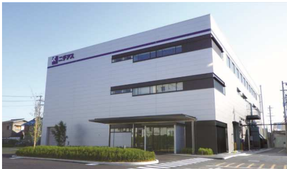
BCP 対策として 2013 年に建て替えられた ニチアス羽島工場管理棟
