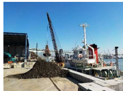
船舶による荷揚げ作業
