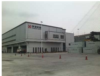
2,800トン/日の処理量を誇る 上海徐浦ごみ中継施設(中国)
