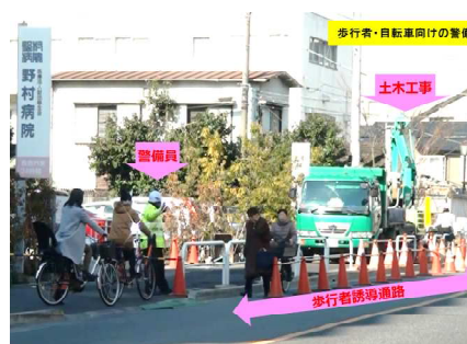
歩行者誘導現場
