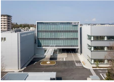
環境に配慮した建材を用い CASBEE 認証A ランクを取得 した三田工場
