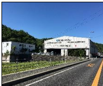
ニホンケミカル本社工場 (広島県三原市)
