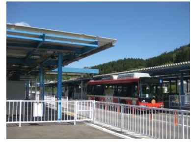
社会インフラ整備への貢献 「BRT専用道の整備」
