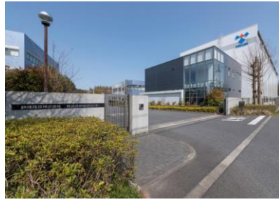
脱炭素社会の実現、施工実 験棟建設による「ZEB 取得」
