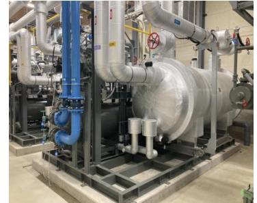
アンモニア冷凍機 (ノンフロン機器) を使用
