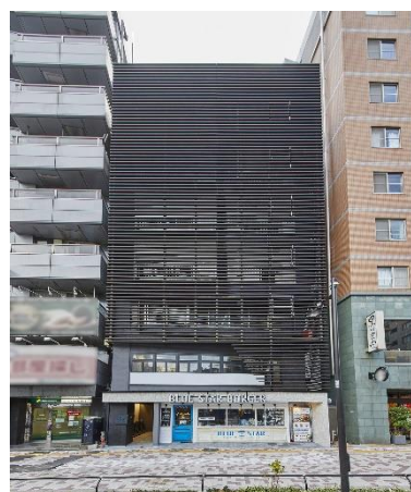
リノベーション工事
