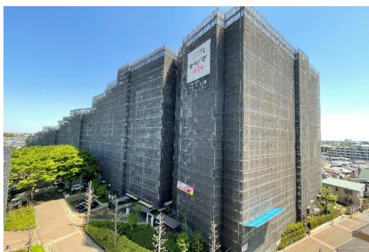
大規模修繕工事
