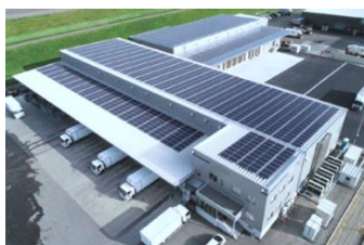
太陽光発電システム
